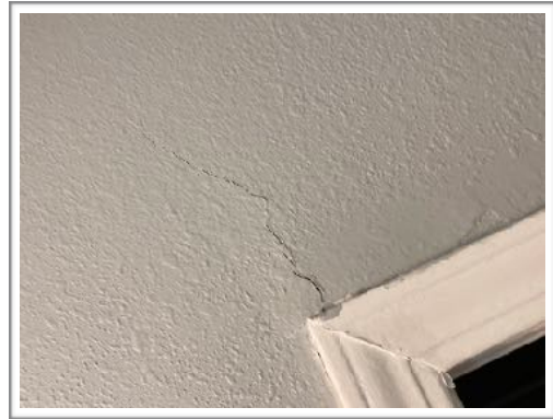
Drywall crack
